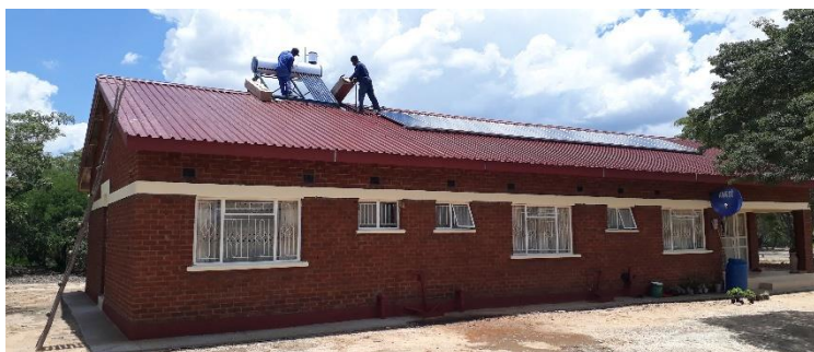
Instalace solárních el. panelů a kolektorů na ohřev vody
